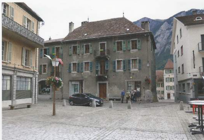
Façade ouest bâtiment FAA Saint-Maurice
