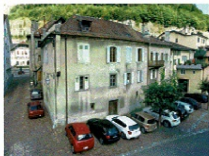
Façade est avant rénovation des fenêtres et volets
