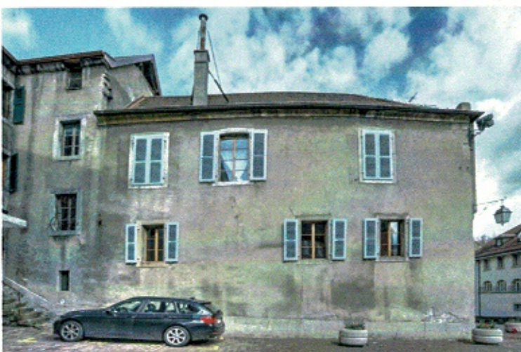
Façade sud-est – fenêtres et volets remplacés à l'identique
