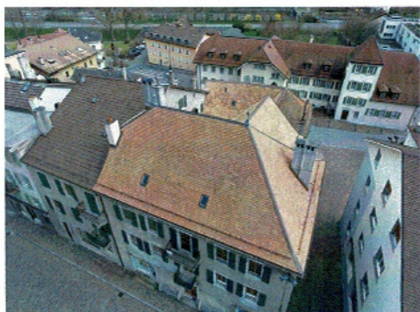
Façade ouest et toiture
