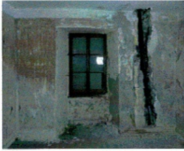
Salle de travail – 4.1 (est du bâtiment) avant rénovation
