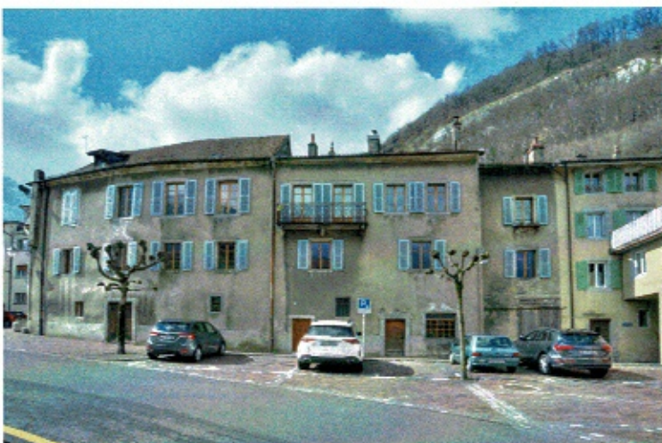
Façade est – fenêtres et volets remplacés à l'identique
