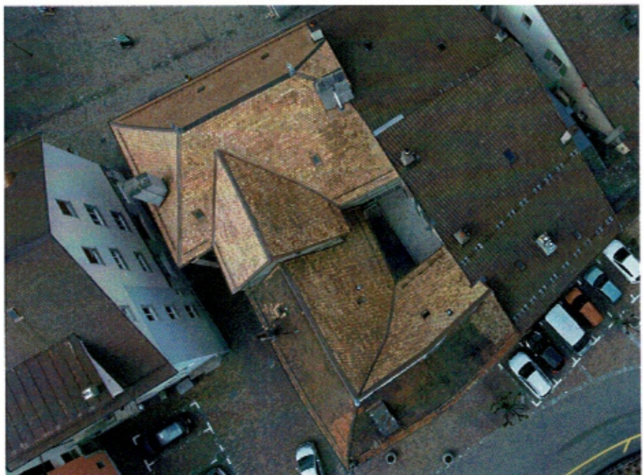
Grand-Rue 74 – toits rénovés au-dessus de la cour intérieure
