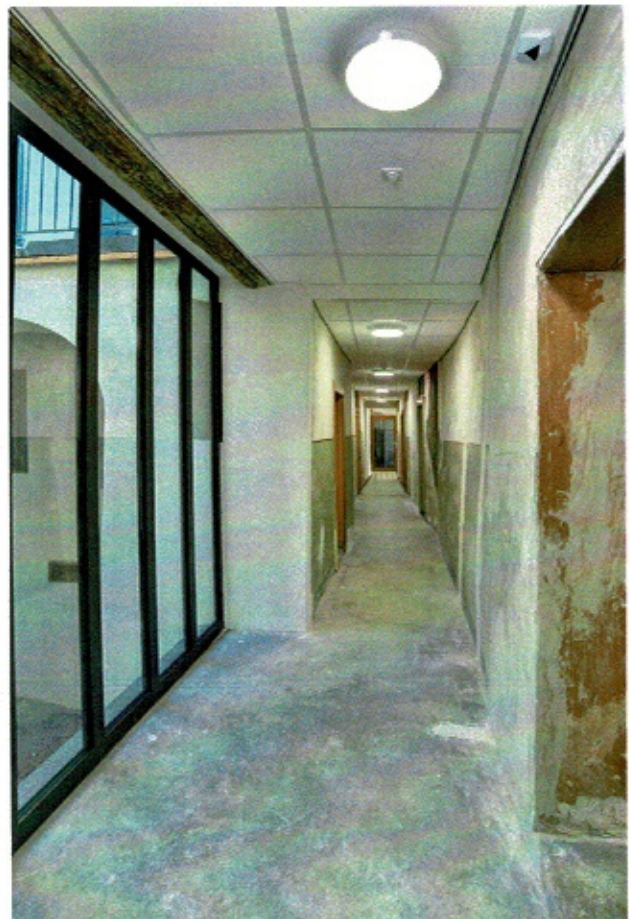
Baie vitrée sur la cour et enfilade vers les entrepôts (direction nord)
