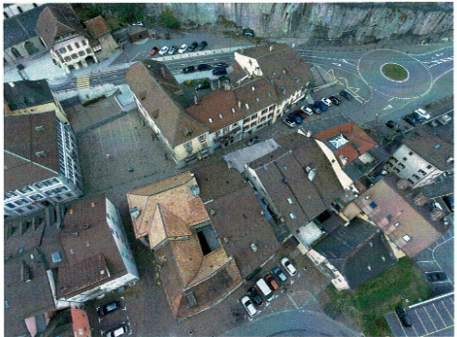
A l'est de l'Abbaye, la Place du Parvis avec, au sud, l'Hôtel de Ville et à l'est le bâtiment de la Grand-Rue 74 et ses toits restaurés
