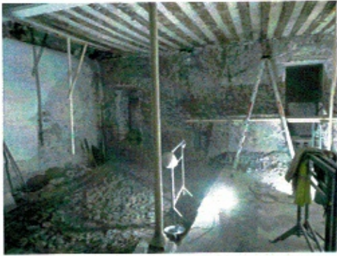
Salle d'exposition en cours de rénovation – 3.1
